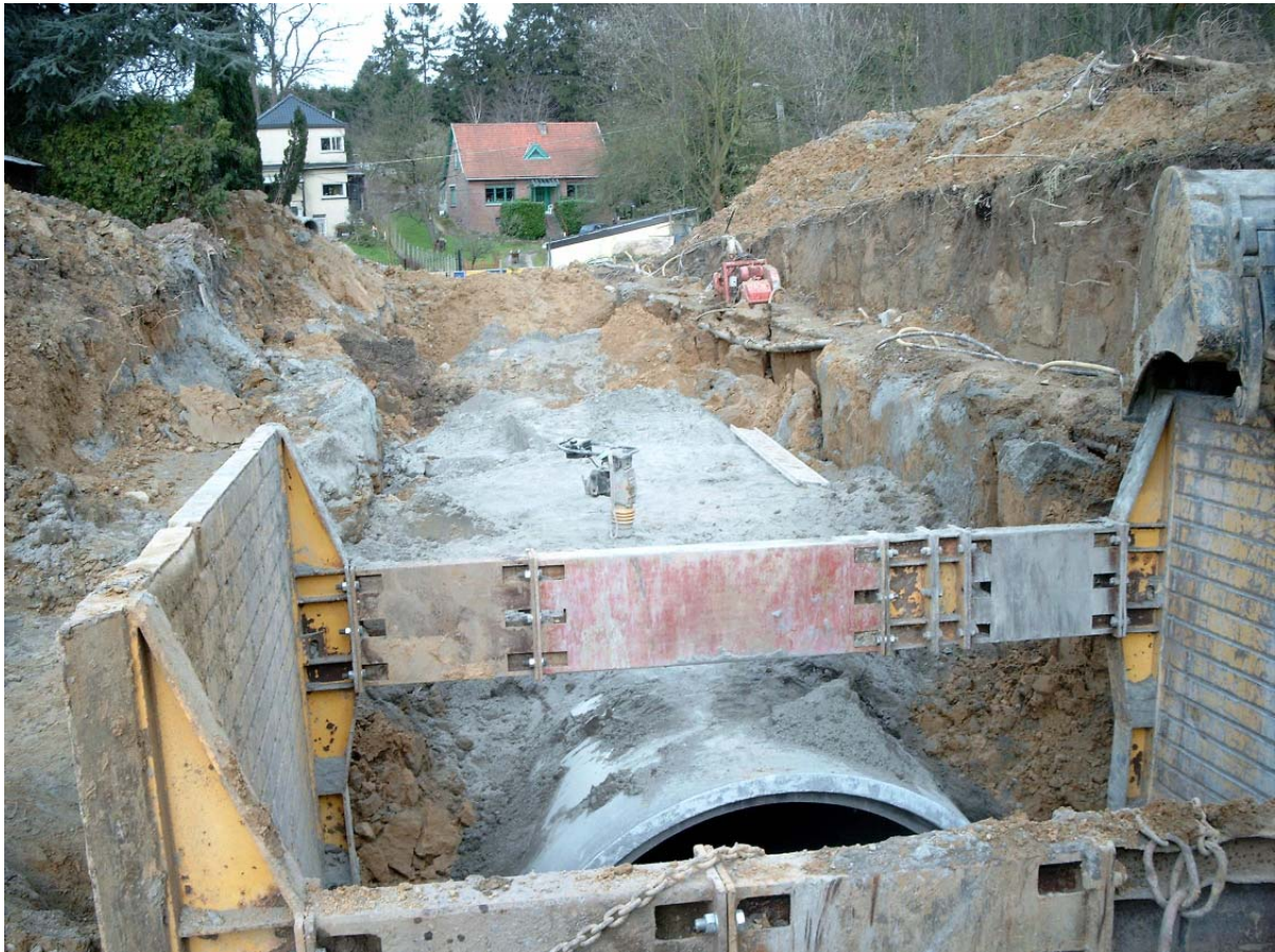
Bouw van de ondergrondse berging achter het voormalige klooster in 2007. Zicht richting Degelaenstraat.
